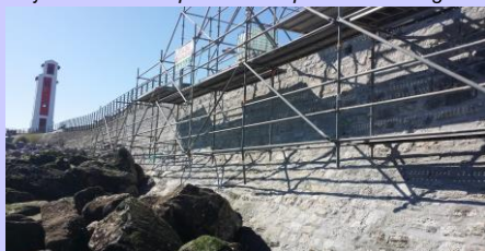
Rejointoiement de parement depuis échafaudage.
