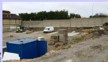
Mur d'enceinte DCNS à RUELLE
