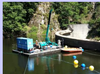
Plateforme de travail pour pompage
